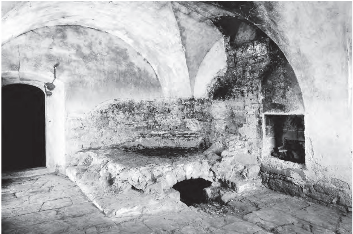
Abb. 20: Reste des Backofens im Keller mit darunter befindlichem Gewölbe. Aufnahme aus dem Jahr 1969 (Landesamt für Denkmalpflege im RP Stuttgart, Bildarchiv der Bau- und Kunstdenkmalpflege Tübingen, Fotograf Helmut Hell, Arch.-Nr. 4672).
