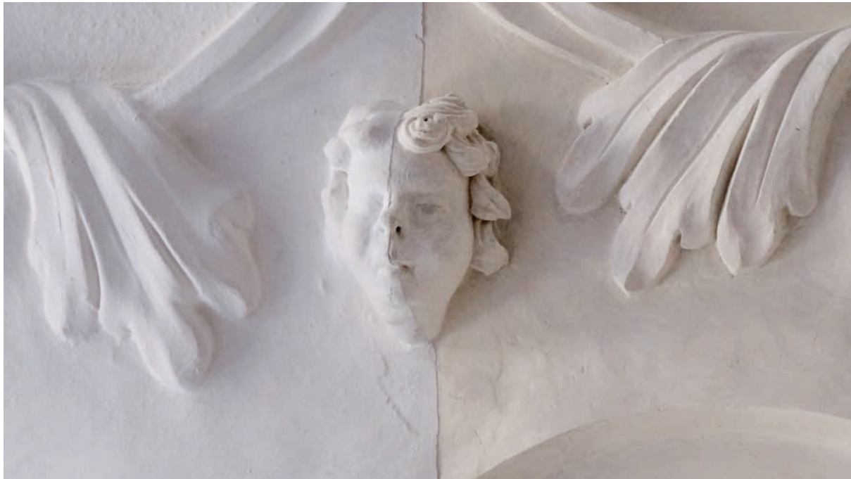
Abb. 23: Deckenstuckatur im Konventsaal. Teilfreilegung der Deckenstuckatur im Konventsaal 2019. Vermutlich waren in Binsdorf Stuckateure der Wessobrunner Schule tätig (Foto: Isabel David 2020).
