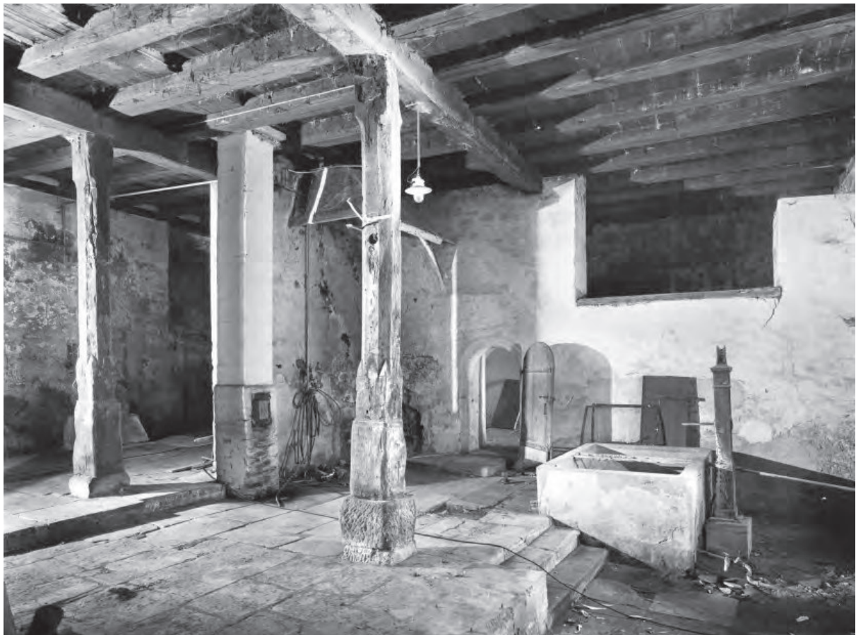
Abb. 19: Die Waschküche mit Feuerstelle und Brunnen sowie der Durchgang zum sogenannten Bädle (Landesamt für Denkmalpflege im RP Stuttgart, Bildarchiv der Bau- und Kunstdenkmalpflege Tübingen, Fotograf Helmut Hell, Arch.-Nr. 4661).
