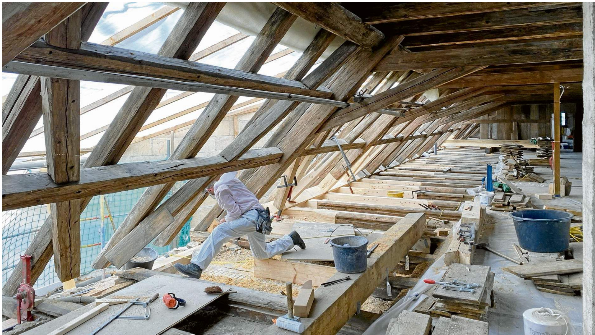
Hinter den großen Planen wird seit Mai 2021 im Dachraum mit Hochdruck gearbeitet.
